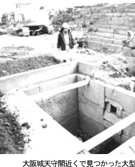
大阪城天守閣近くで見つかった大型「集水枘」。
