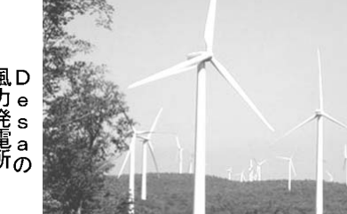
Desaの風力発電所
