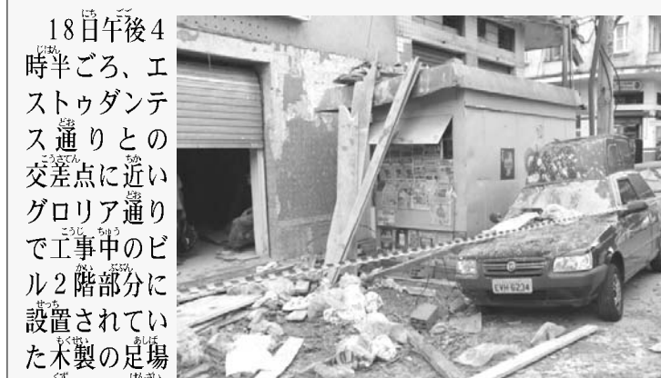
レンガ片などが散乱する事故現場
