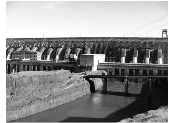
世界で初めての工法で作られた仮排水路(手前のタービン4本部分)
