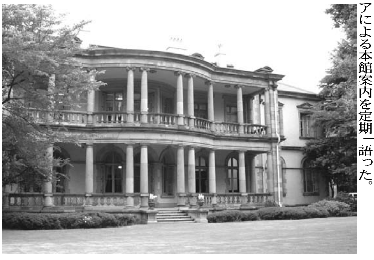
旧島津公爵邸(現清泉女子大本館)＝東京都品川区
