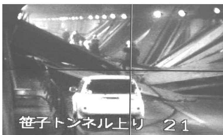
中日本高速道路八王子支社の監視カメラのモニターに映し出された中央自動車道笹子トンネル内の事故現場。落下した天井板が散乱し、救助隊員と見られる人の姿が映っている。
