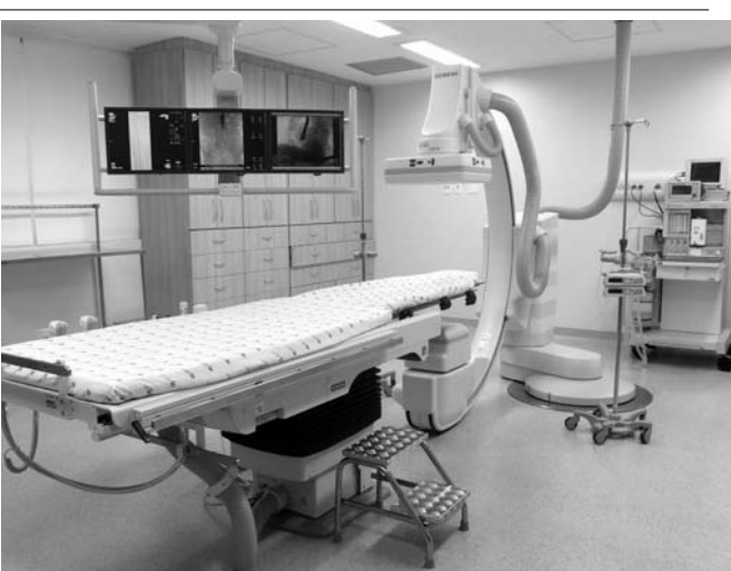
日伯友好病院6階に設置された最先端の血行動態検査機材
