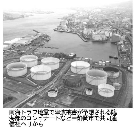
南海トラフ地震で津波被害が予想される臨海部
