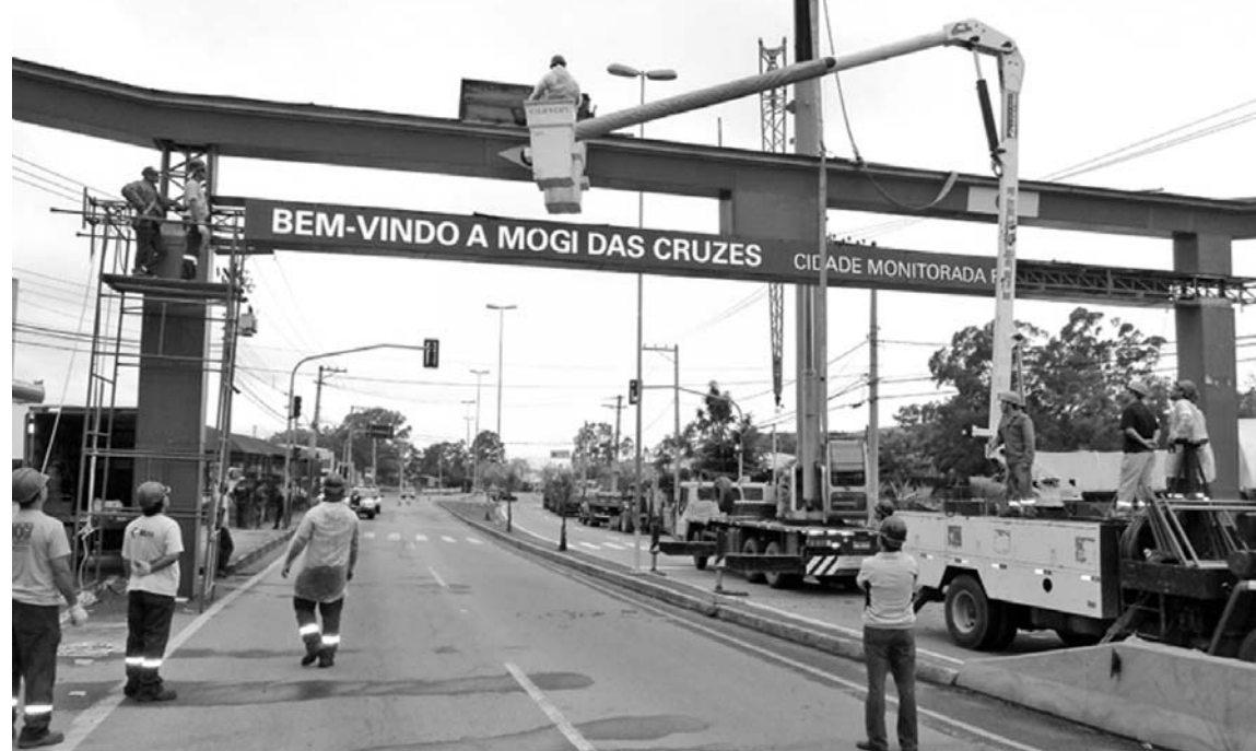
鳥居の撤去作業の様子(モジ市役所のサイトより)
