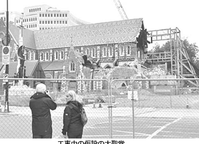
工事中の仮設の大聖堂
