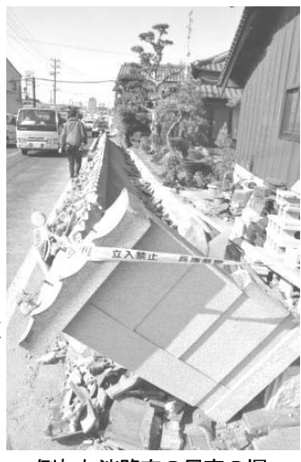
倒れた淡路市の民家の塀
