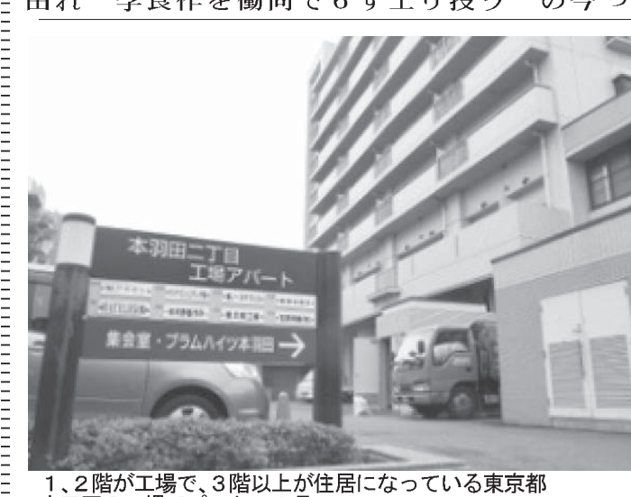
1、2階が工場で、3階以上が住居になっている東京都大田区の工場アパート＝6月
