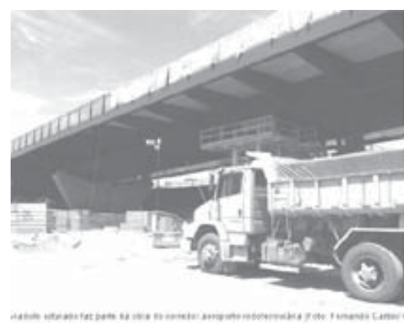
この高架道路は、空港と市内のバスターミナルを繋ぐ道路の一部。工事が続いている（G1サイトより）
