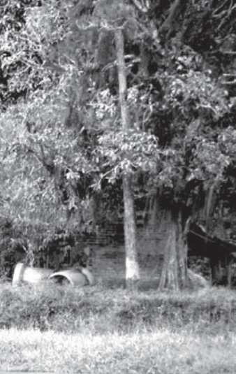
リベラ河の対岸にある旧桂植民地の崩れた家屋
