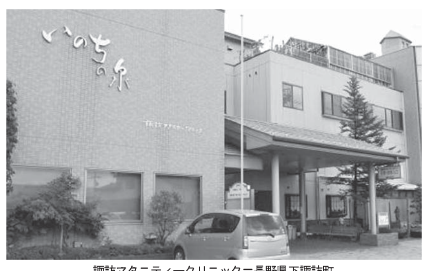
諏訪マタニティクリニック=長野県下諏訪町
