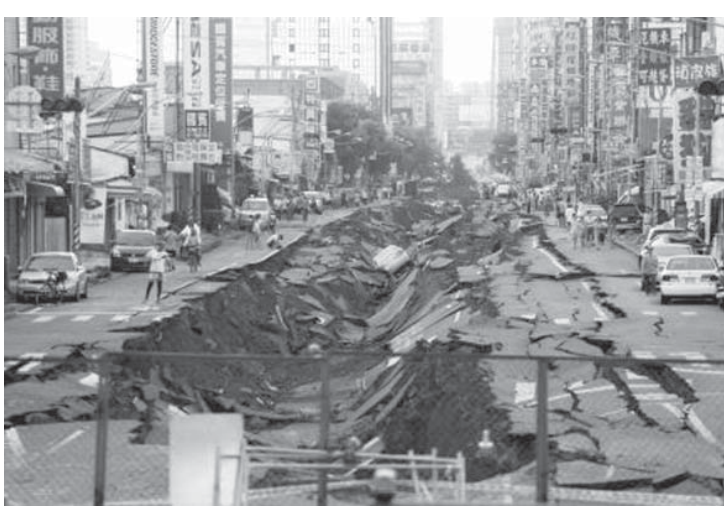
1日、台湾・高雄市で起きた大規模爆発で陥没した道路(新華社=共同)
