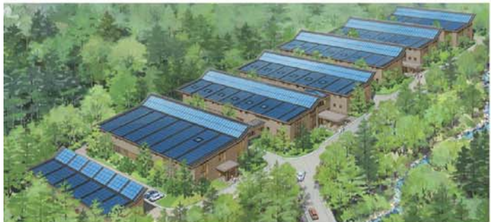
大自然に囲まれたオフィス。屋根は太陽光パネル
