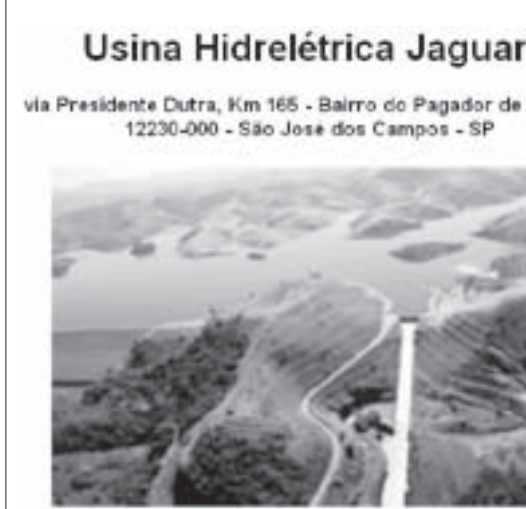
ジャグアリの水力発電所(Cesp公式サイトより)
