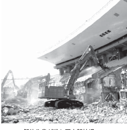
解体作業が進む国立競技場
