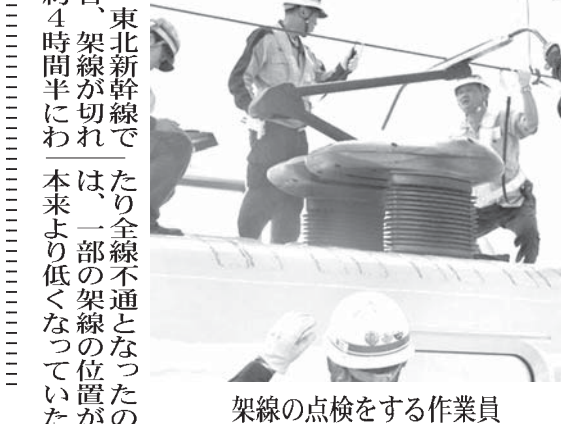
架線の点検をする作業員
