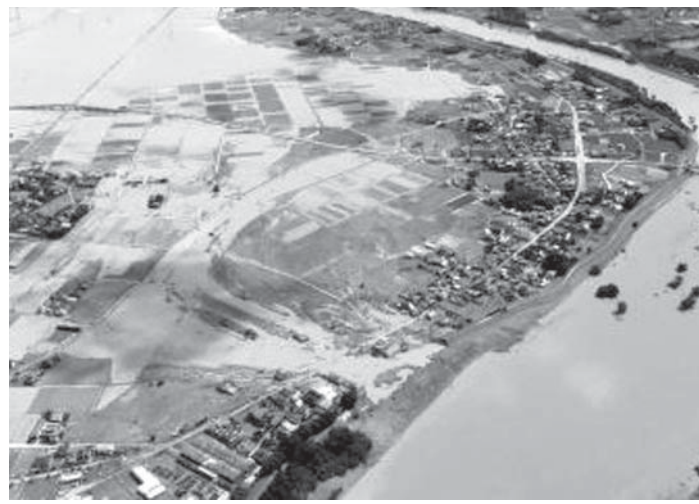
鬼怒川決壊「越水破堤」か 国交省調査委が現場を視察した
