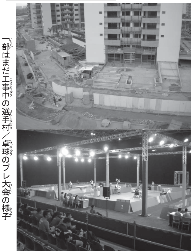
一部はまだ工事中の選手村/卓球のプレ大会の様子
