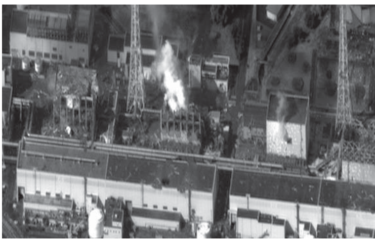
福島第一原子力発電所、2011年3月16日撮影 (Earthquake and Tsunami damage-Dai Ichi Power Plant, Japan)
