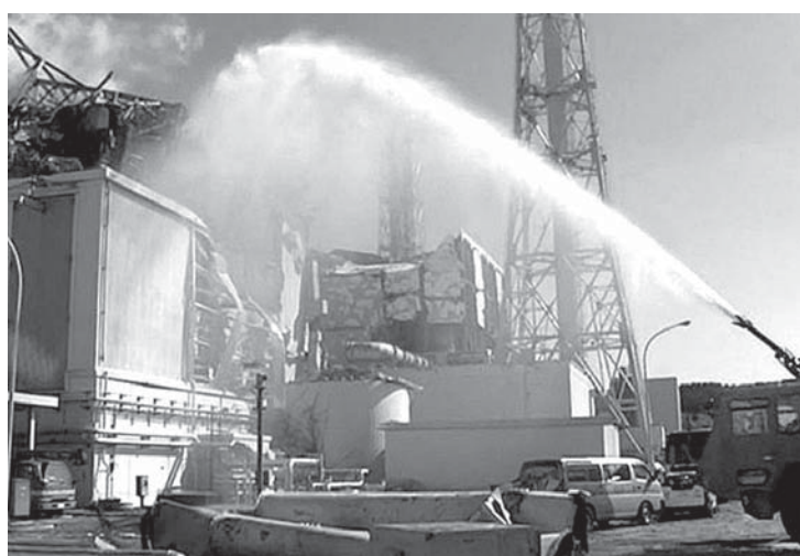
原発を冷却するため行われた放水作業
