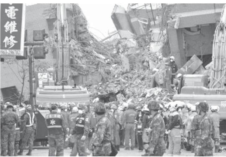
倒壊現場では救助活動が続く
