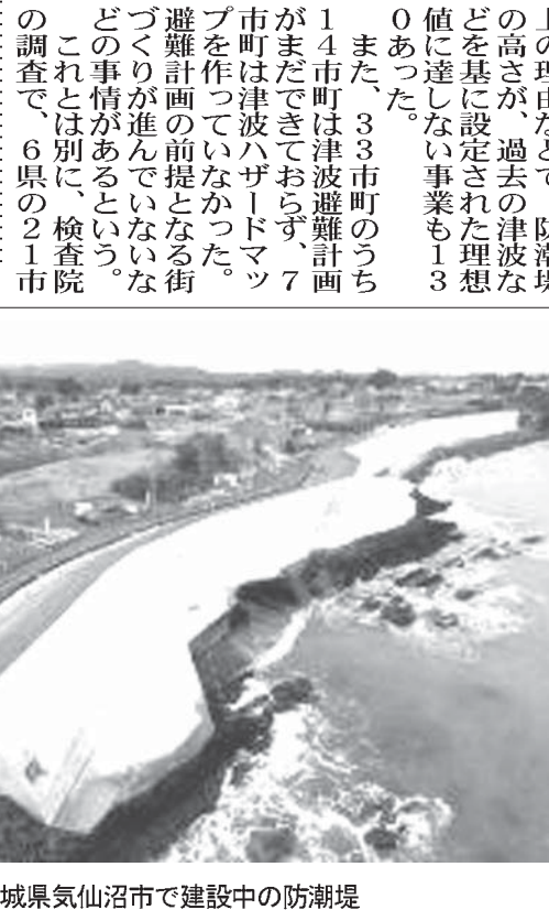
宮城県気仙沼市で建設中の防潮堤
