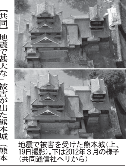
熊本城(上)の様子。地震で被害を受けた石垣(下)は2012年3月19日撮影(共同通信社)
