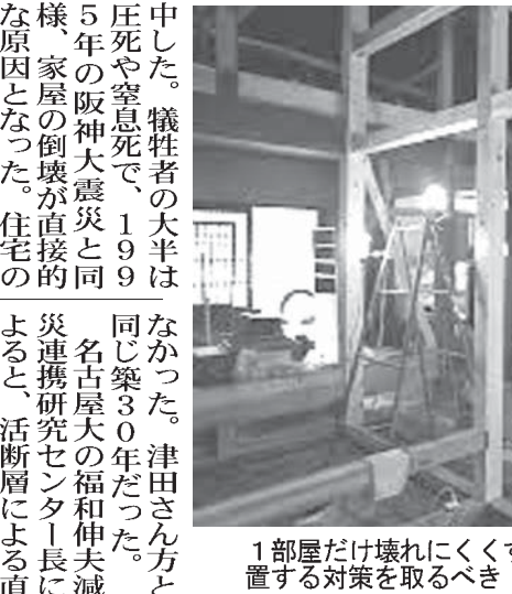
1部屋だけ壊れにくくする「耐震シェルター」を設置する対策を取るべき
