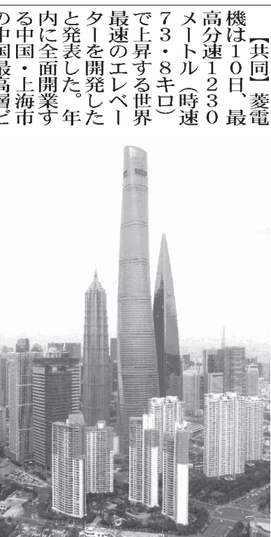
世界最速のエレベーターが設置される中国最高層ビル「上海中心」(上海タワー)
