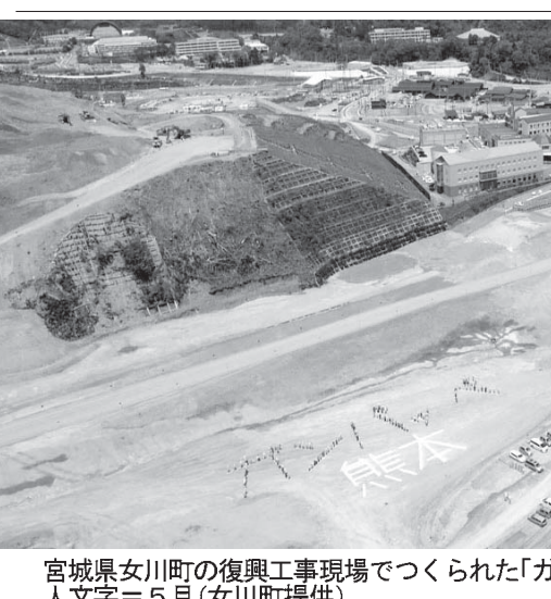
宮城県女川町の復興工事現場でつくられた「ガンバツペ 熊本」の人文字(5月、女川町提供)
