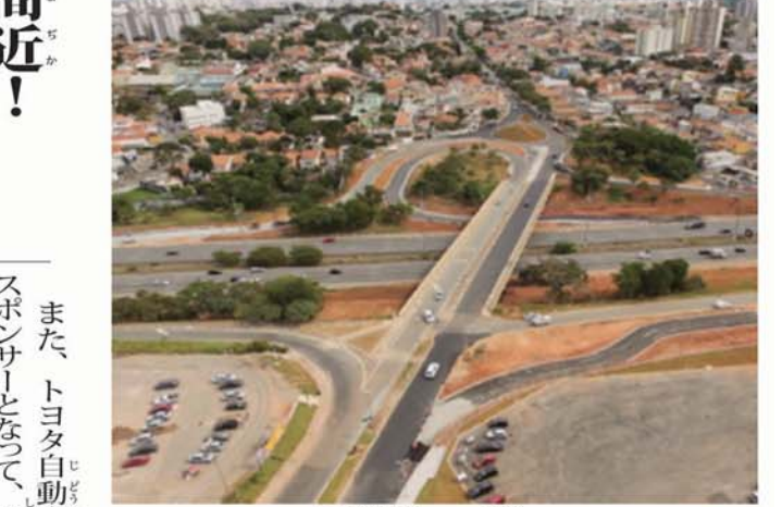
新規開通した道路
