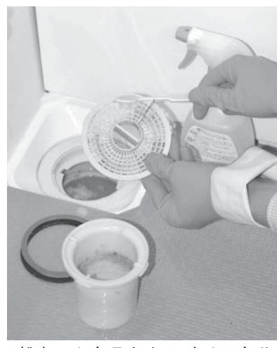
排水口は、部品を外して細かい部分の汚れを歯ブラシで除去する
