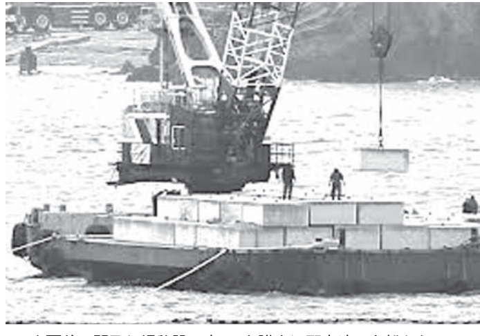
米軍普天間飛行場移設工事で、名護市辺野古沖で台船からコンクリートブロックを移し替えるクレーン作業船
