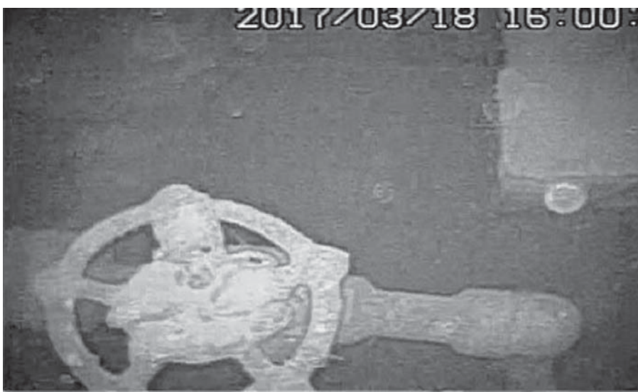
自走式ロボットが撮影した原子炉格納容器底部の画像。ロボットのバルブなどが写っている。18日国際原子力研究所提供
