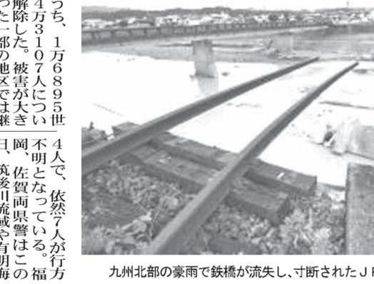
九州北部の豪雨で鉄橋が流失し、寸断されたJR久大本線の線路
