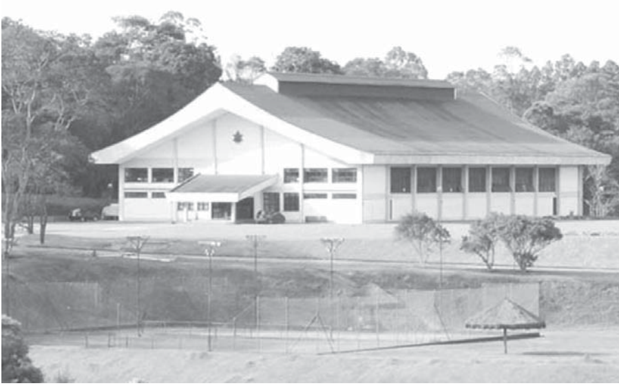
国土館センターの立派な体育館(文協サイトより)
