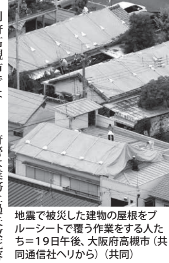
地震で被災した建物の屋根をブルーシートで覆う作業をする人々。19日午後、大阪府高槻市（共同）
