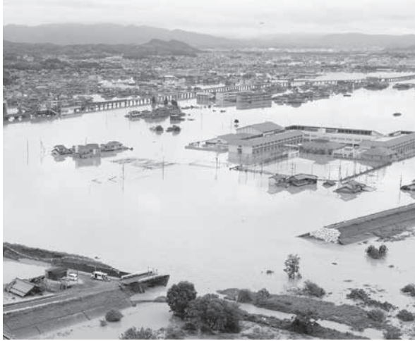
水に漬かった岡山県倉敷市真備町地区。手前は決壊した堤防=8日(共同)
