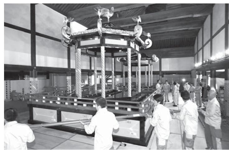
京都御所、紫宸殿で報道陣に公開された「即位礼正殿の儀」で新天皇が使う「高御座」の解体作業。奥は「御帳台」=20日午後、京都市(共同)
