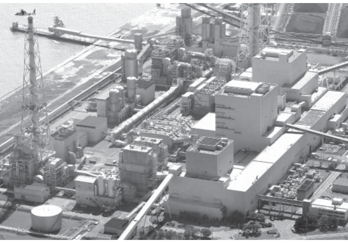
地震の影響で停止した北海道電力の苫東厚真火力発電所＝6日午後0時21分、北海道厚真町（共同通信社機から）＝共同
