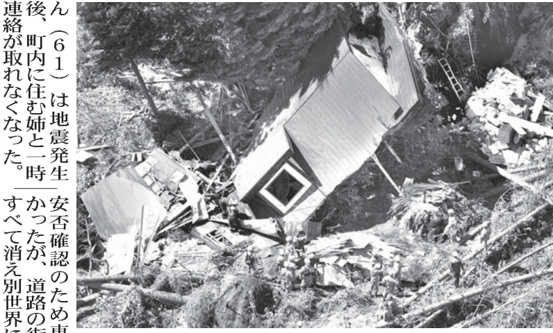
地震による土砂崩れで倒壊した建物の周辺を捜索する警察官ら＝6日午後0時26分、北海道厚真町（共同通信社機から）＝共同
