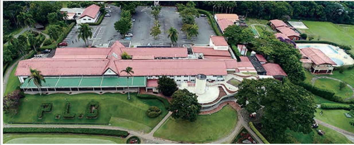
クラブ施設の全景
