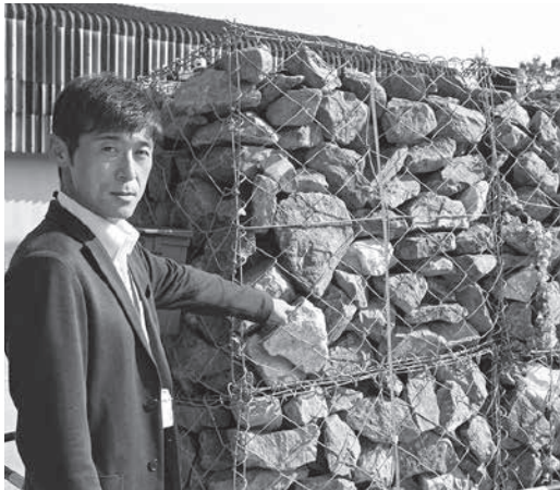
金網で覆った「蛇籠」構造の石積み壁について説明する防災科学技術研究所の中澤博士主幹研究員=5日、茨城県つくば市(共同)
