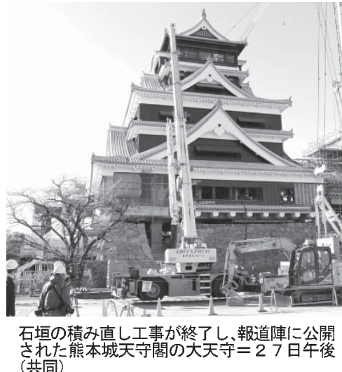
石垣の積み直し工事が完了し、報道陣に公開された熊本市大天守の石垣(27日午後、共同)
