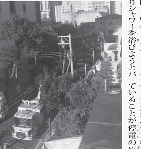
突如始まった電気工事
