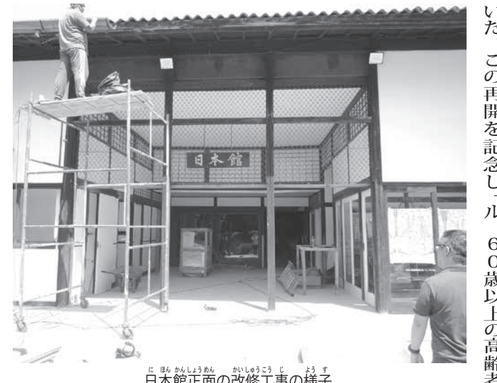
日本館正面の改修工事の様子
